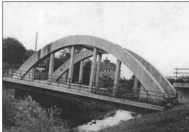
Poškozený železobetonový most přes Ondřejnici ve Staré Vsi nad Ondřejnicí
